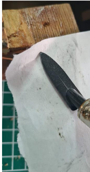
Figura 95 Remoción de adhesivo original con plancha térmica con calor controlado
