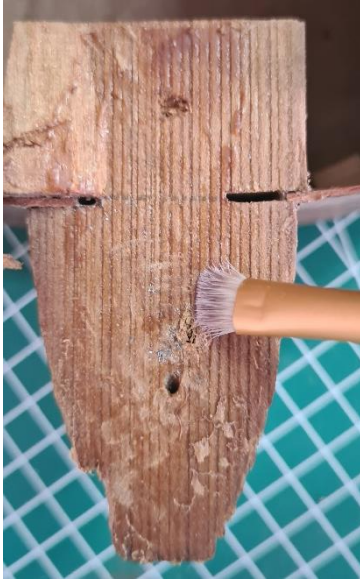
Figura 94 Limpieza de superficie de unión con brocha
