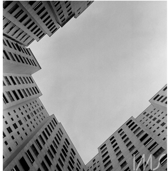
Figura 6: “Fachada interior do edifício São Borja
