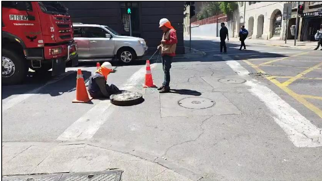
Figura 9: Reparaciones en calle San Martín
