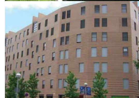
Viviendas en Sabadell, Barcelona.
