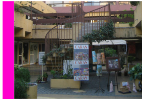
EDIFICACION OBSOLETA, TIPOLOGIA GALERIA ABANDONADA, NECESITA UNA RENOVACION
