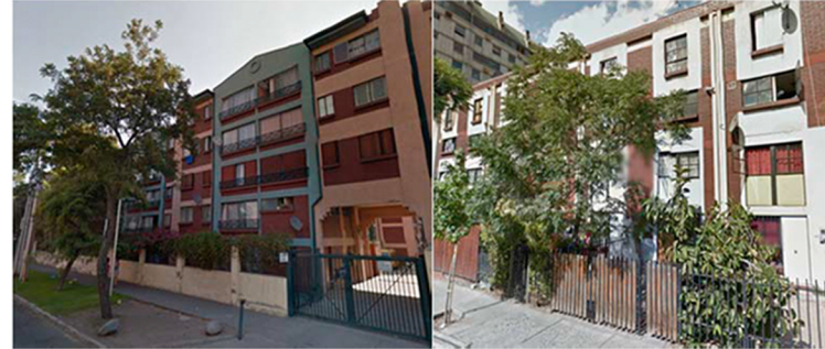
5. Edificación Primera Renovación.
