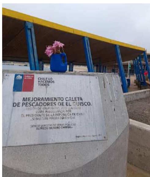
Foto 18: Memorial de modernización de la Caleta El Quisco
