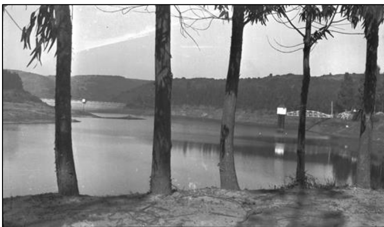
Einar Altschwager/ Tranque de la luz (Pretil y Torre de Válvulas) 1930 Placilla de Peñuelas, Valparaíso.
