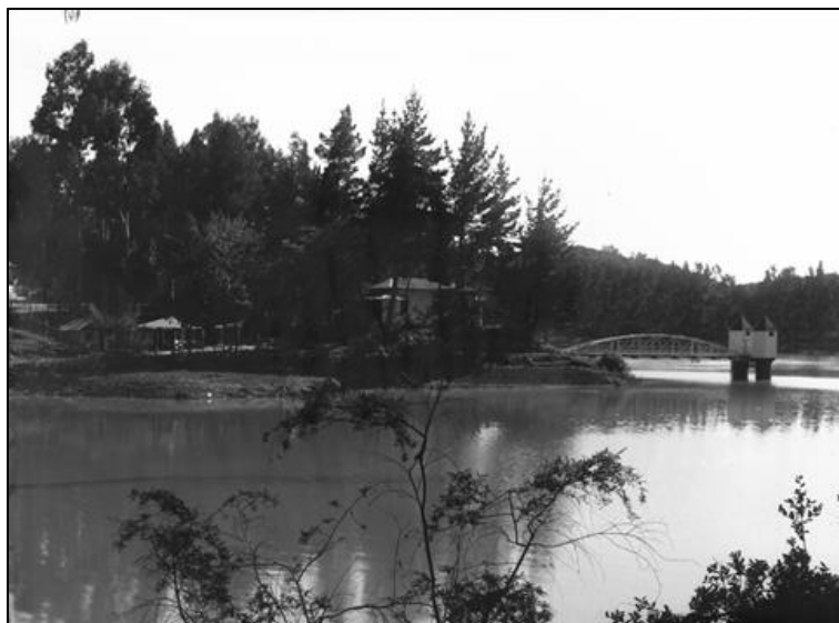
Einar Altschwager/ Tranque de la luz (Chalet y Torre de Válvulas) 1930 Placilla de Peñuelas, Valparaíso.
