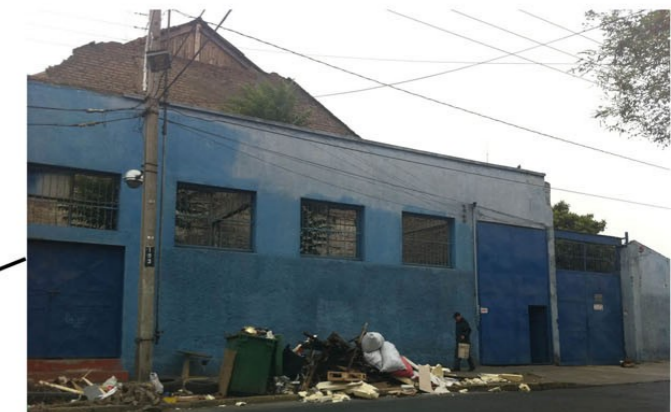
ZONA DE INDUSTRIA EN DETERIORO
