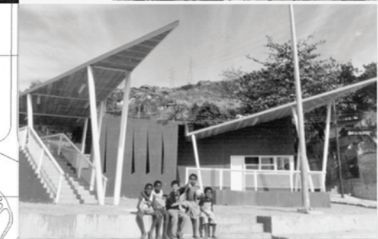
Edificio de usos comunitarios de Fubá
