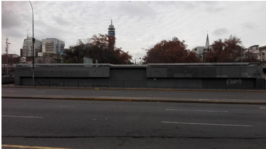
Fotografía 36: Pizarro, N. 2017. Vista desde Poniente. Fotografía. Archivo personal
