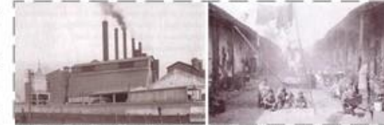
ANTIGUA ESTACIÓN GENERADORA MAIPOCHO Y CONVENTILLO DE PRINCIPIOS DEL SIGLO XX.
