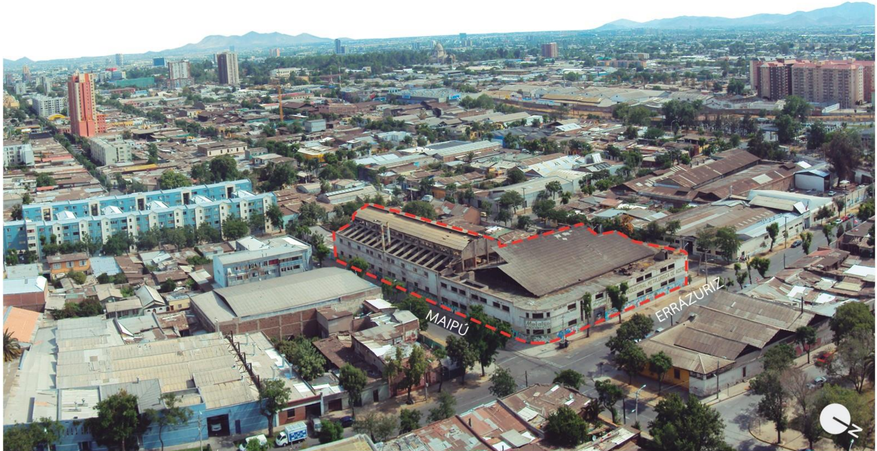
VISTA PANORÁMICA DEL EDIFICIO HACIA EL SUR PONIENTE DESDE EDIFICIO PARQUE DE LOS REYES
