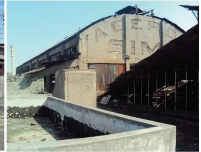
TECHO EDIFICIO MAIPU
