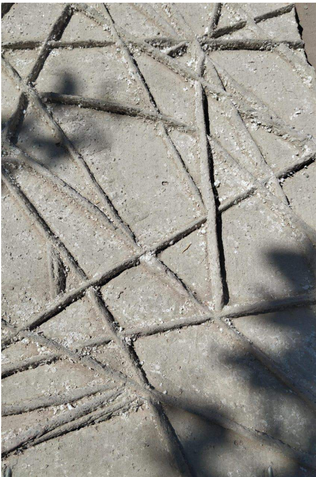
Figura 21: Segundo registro fotográfico de detalle de plancha de hormigón intervenida. 2023.
