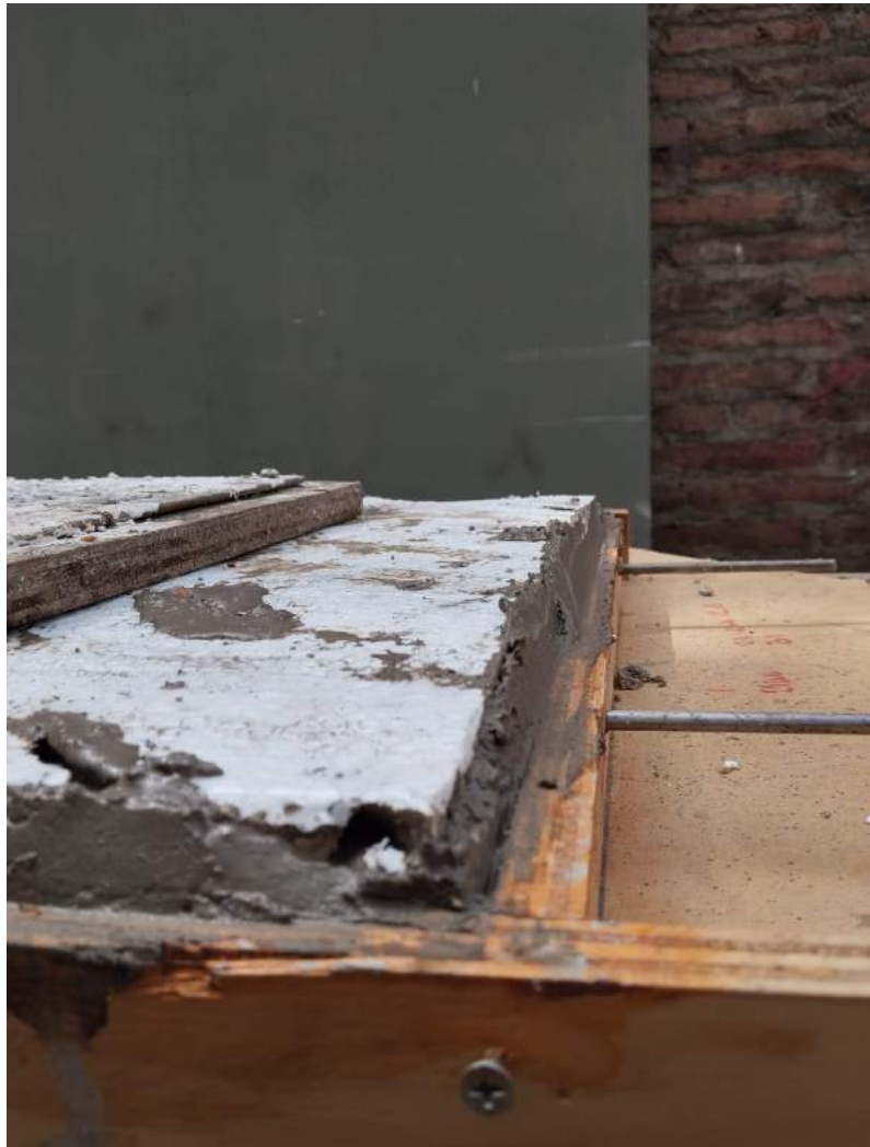
Figura 16: Registro fotográfico de detalle de preparación de plancha de hormigón. 2023. Autoría propia.
