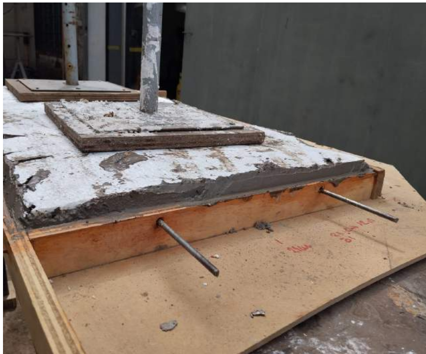
Figura 18: Registro fotográfico de preparación de plancha de hormigón. 2023. Autoría propia.
