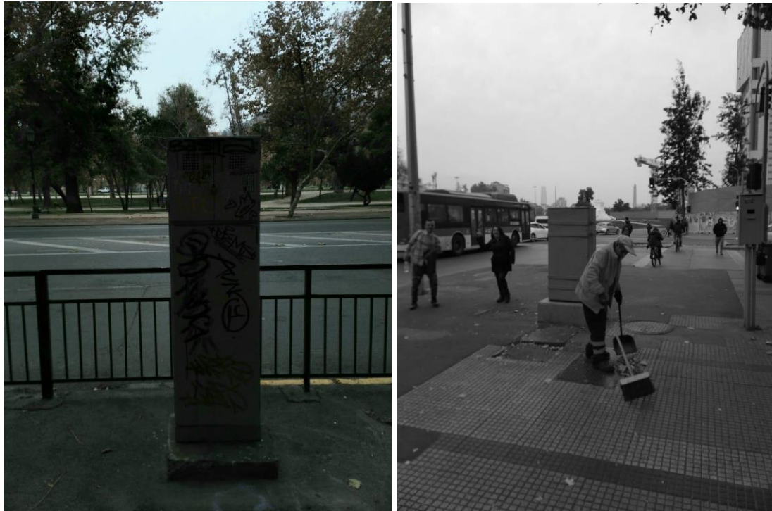
Figura 5 y 6. Referencias fotográficas de cajas eléctricas. Foto 5 tomada en Av. la Florida, foto 6 Plaza de la Dignidad. Imágenes de “autoría propia”.
