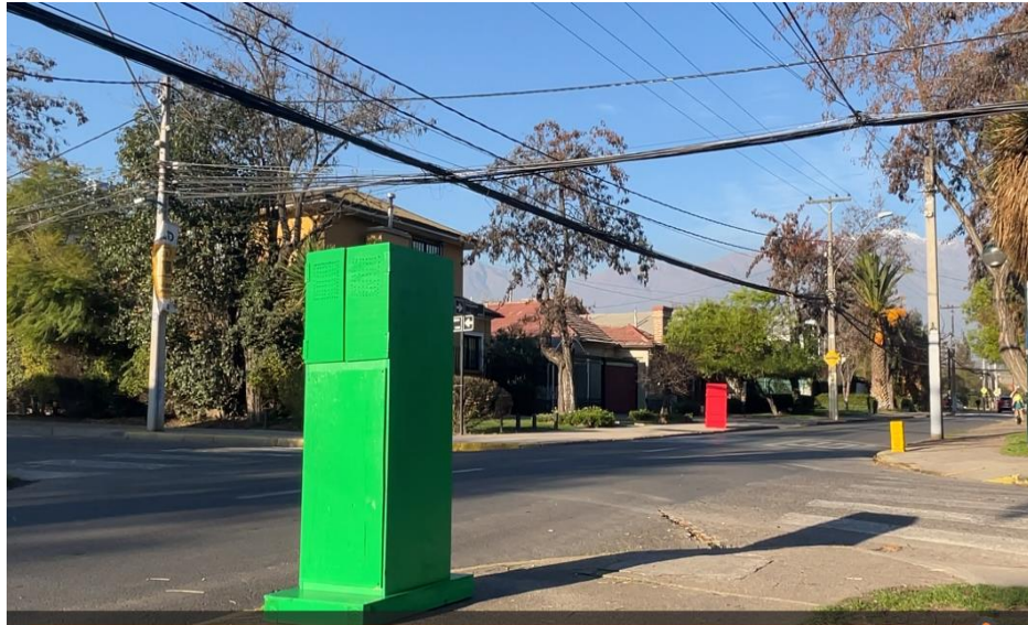
Figura 7. Primeras construcciones de cajas. Instalación en vía pública. Indagación de montajes en distintos campos geográficos. Foto de “autoría propia”.
