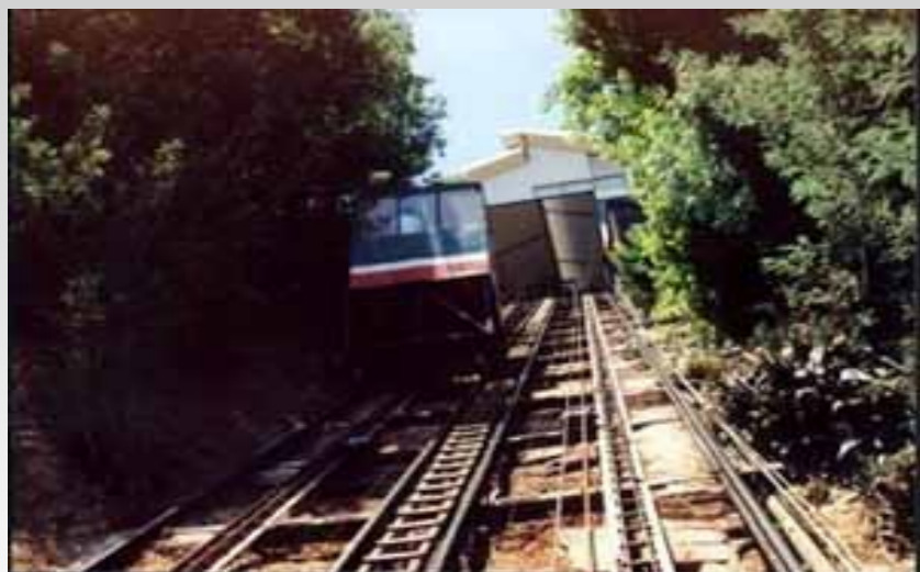
ASCENSOR EL PERAL
