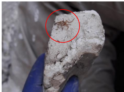
Imagen 36: Castro, F. 2017. Presencia de xilófagos y arácnidos en molduras continuas. Fotografía. Archivo personal.
