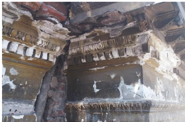
Imagen 33: Castro, F. 2017. Daños de humedad por escurrimiento de agua lluvia, fachada Huérfanos, etapa 2. Fotografía. Archivo personal.
