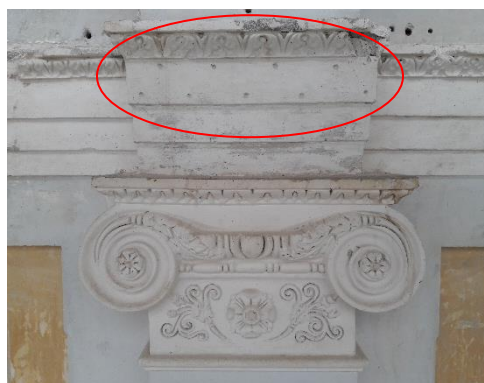
Imagen 48: Castro, F. 2017.Consolidación de arquitrabe y ORE 25, ejemplo de consolidación ideal. Fotografía. Archivo personal.
