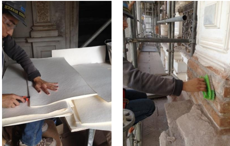
Imagen 14: Castro, F. 2017. Proceso de desalación, corte de celulosa y limpieza de muro. Fotografías. Archivo personal.
