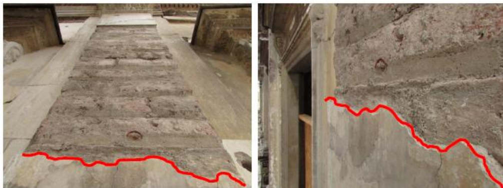
Imagen 7: Dirección de Arquitectura, MOP. 2014. Ejemplo de retiro de estuco, Fachada San Martín. Fotografía. Recuperado de: (Públicas, 2014, pág. 220)
