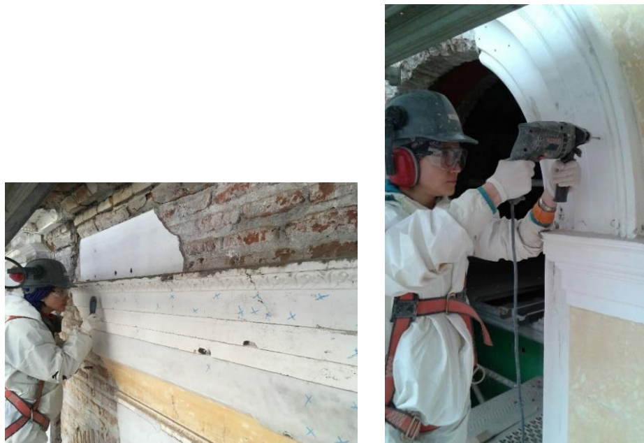
Imagen 17: KALAM. 2017. Proceso de consolidación. Detección de zonas sopladas e inicio del proceso de inyección. Fotografía. Recuperado de: Restauración Palacio Pereira y reposición edificios CMN y DIBAM.
