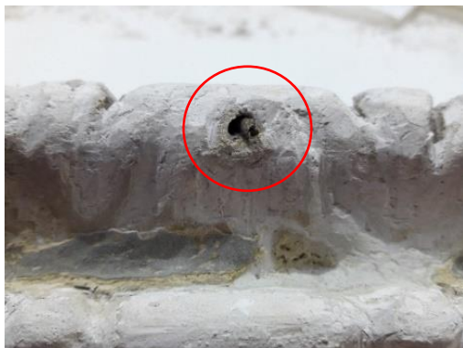
Imagen 36: Castro, F. 2017. Presencia de xilófagos y arácnidos en molduras continuas. Fotografía. Archivo personal.
