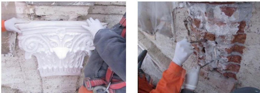
Imagen 22: Castro, F. 2017. Proceso de instalación de capitel, fachada San Martín, etapa 1. Fotografía. Archivo personal.
