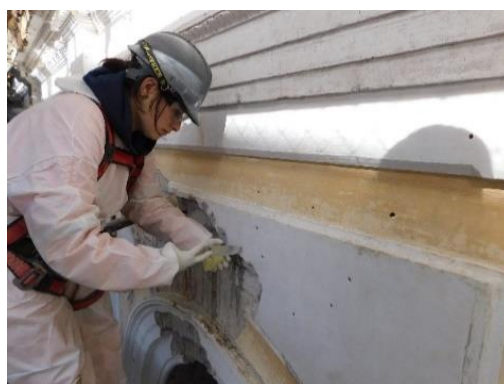
Imagen 19: KALAM. 2017. Proceso de consolidación, inyección de solución de Acril33 más agua destilada. Fotografía. Recuperado de: Restauración Palacio Pereira y reposición edificios CMN y DIBAM.
