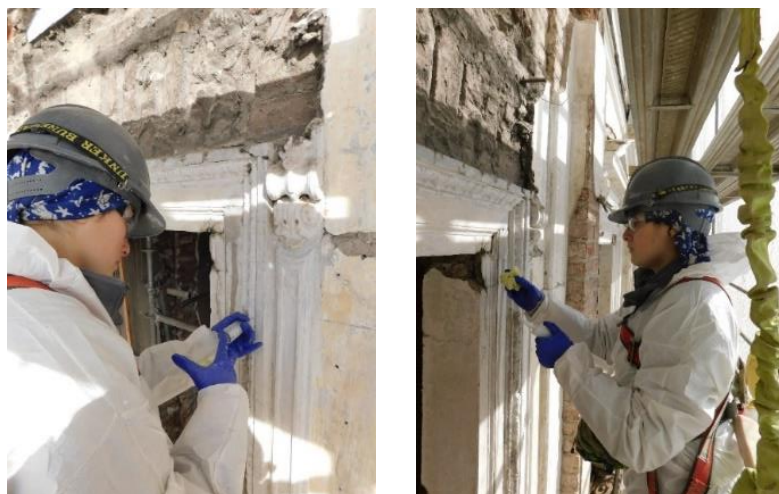
Imagen 18: KALAM. 2017. Proceso de consolidación, inyección de solución de Acril33 más agua destilada. Fotografía. Recuperado de: Restauración Palacio Pereira y reposición edificios CMN y DIBAM.
