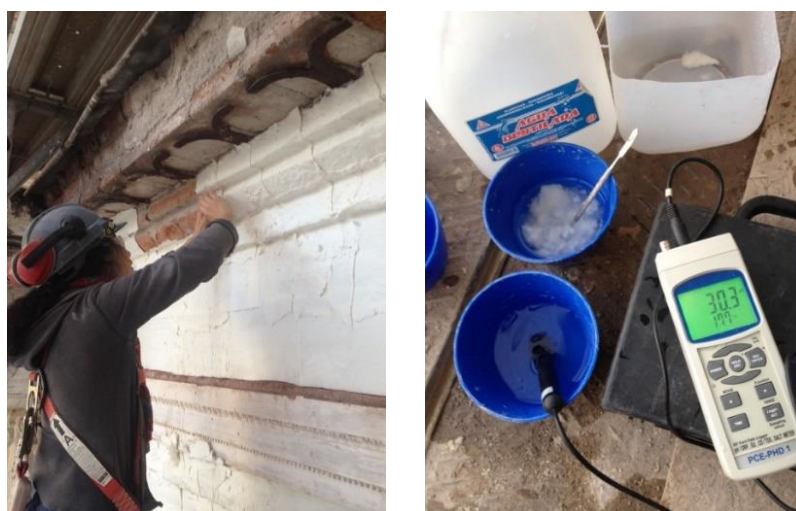
Imagen 16: Castro, F. 2017. Proceso de desalación, aplicación de celulosa en el muro y medición de muestras. Fotografías. Archivo personal.
