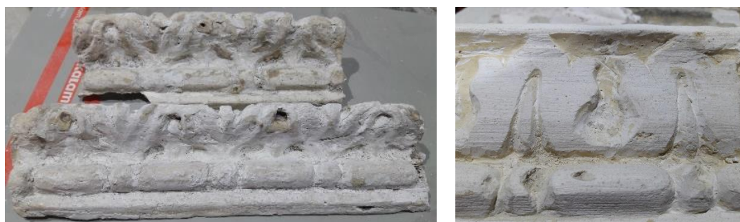
Imagen 37: Castro, F. 2017. Ornamento decapado en fachada. Fotografías. Archivo personal.
