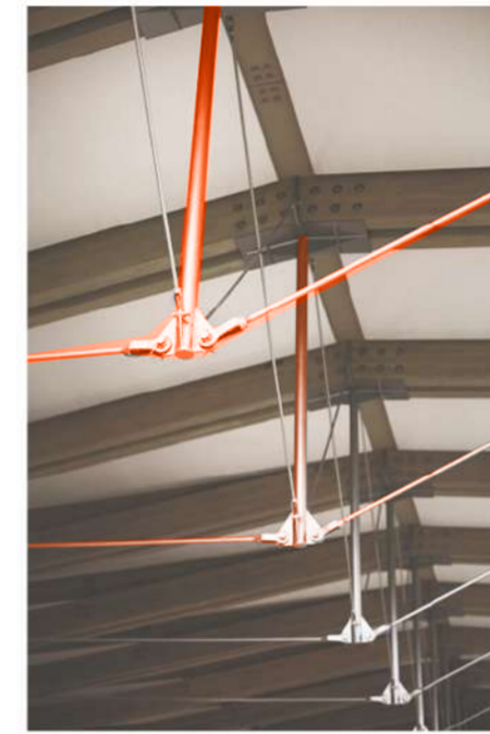
Sistema estructural de madera laminada con anclajes de acero, utilizando cerchas con tensores.
