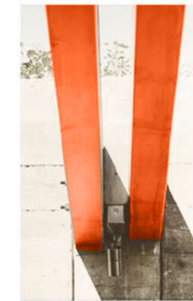
Sistema estructural de madera laminada con anclajes de acero, utilizando cerchas con tensores.
