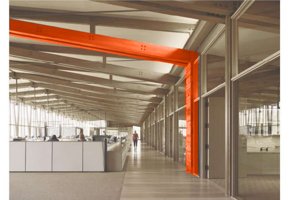
Sistema estructural de madera laminada con anclajes de acero, utilizando cerchas con tensores.
