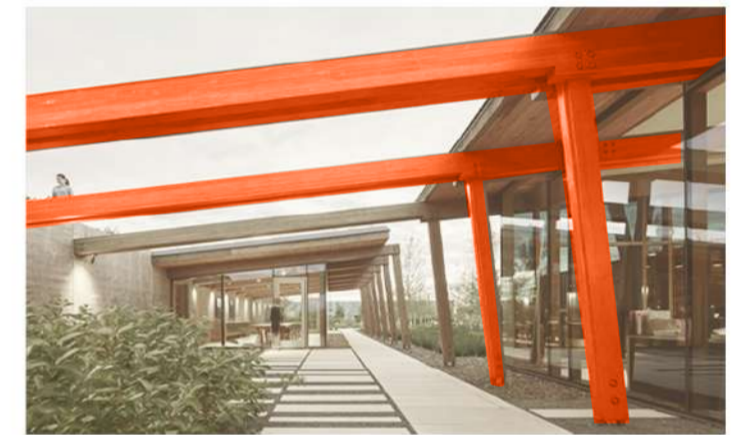
Sistema estructural de madera laminada con anclajes de acero, utilizando cerchas con tensores.
