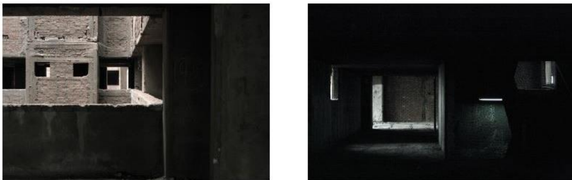
Figura 20 y 21. Hospital del Empleado. Fotografía digital, 2015. Archivo personal.
