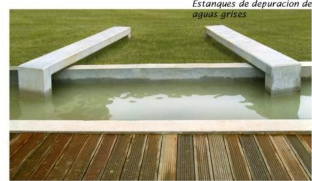
Al mismo tiempo los estanques se utilizan como acopio de aguas, provienen del sistema de aguas existentes en el cerro, de los nuevos canales de aguas lluvias propuestos
