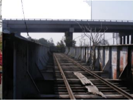
puente La Maquina
