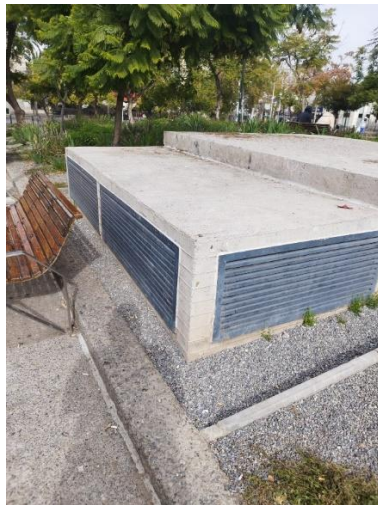
Figura 6. Salida de aire 1 Inés de Suarez.
