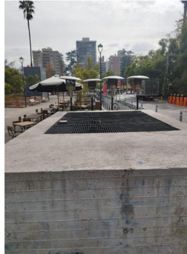
Figura 7. Salida de aire 2 Inés de Suarez
