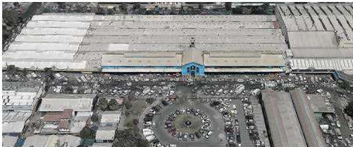
EN LA ACTUALIDAD EL EDIFICIO SOLO CUENTA CON ACCESO POR EL FRONTIS (UNICA CARA VISIBLE DEL MISMO, QUEDANDO PERDIDA EN LOS ESTACIONAMIENTOS)
