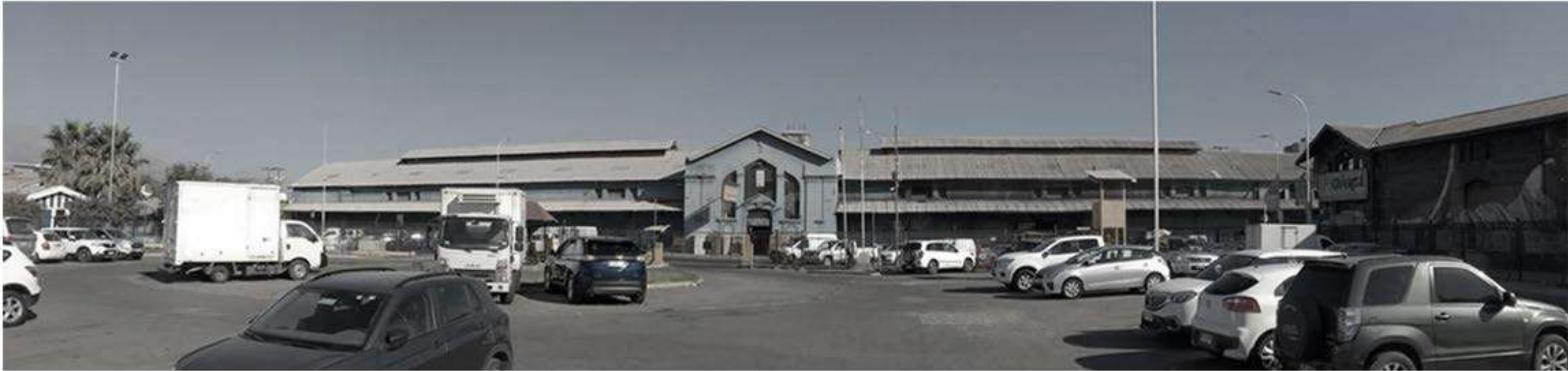
EDIFICIO A INTERVENIR / CONDICION ACTUAL DE BODEGA DE MUEBLES
