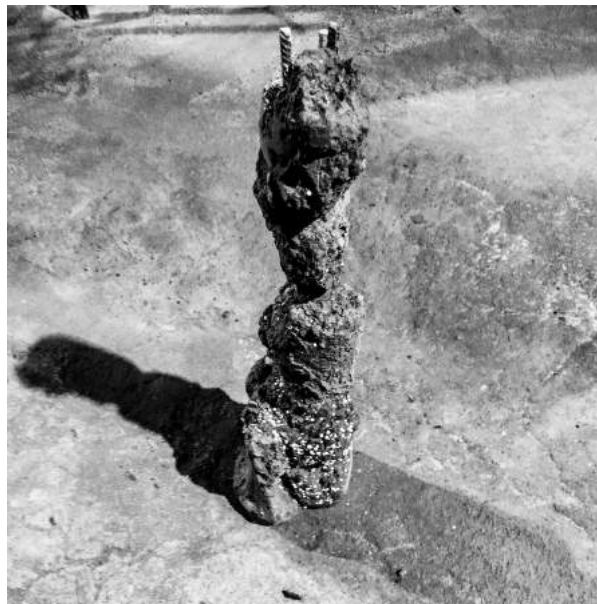
Figura 6: Aproximamiento al hormigón, primer semestre 2023. Archivo personal
