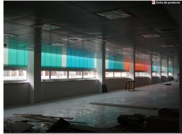
Tabiquería recubierta en policarbonato
