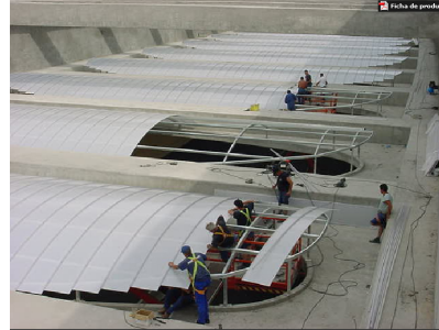
Sistema estructural liviano soporte de la cubierta
