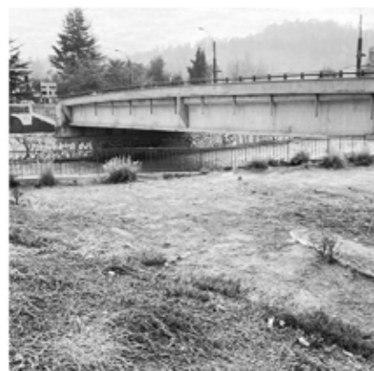
1. Puente Nueva Tobalaba (El Cerro I) Dimensiones: 50 m/2 pistas
