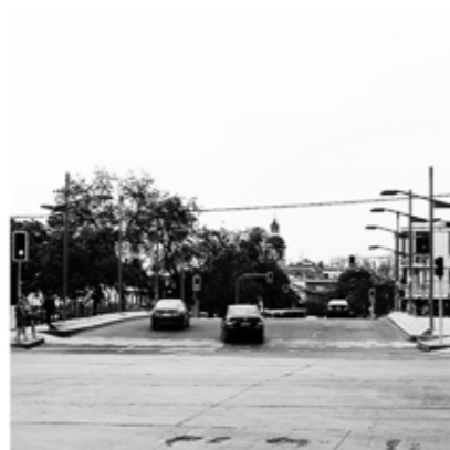
16. Puente del Abasto (Recoleta Oriente) Dimensiones: 40 m/4 pistas
