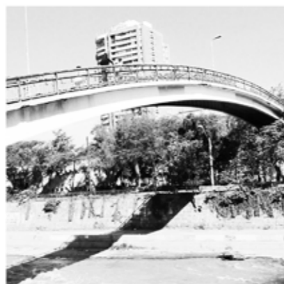
10. Puente peatonal Racamalac Dimensiones: 65 m/peatonal
