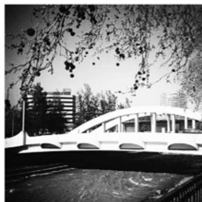
9. Puente del Arzobispo Dimensiones: 45 m/3+2 pistas
