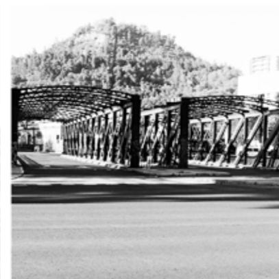
13. Puente Purísima Dimensiones: 40 m/4 pistas Monumento histórico
