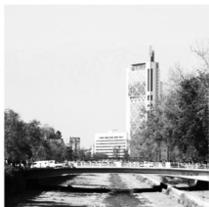
15. Puente Patronato Dimensiones: 40 m/3 pistas
