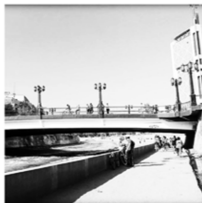
11. Puente Pio Nono Dimensiones: 45 m/4 pistas
