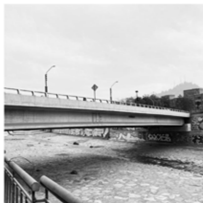
2. Puente Nueva Tajamar (El Cerro II) Dimensiones: 95 m/1 pista
