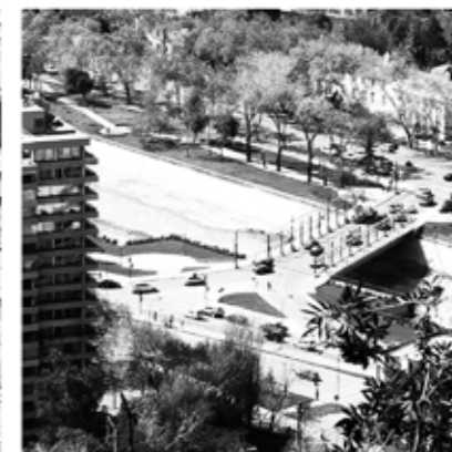
7. Puente La Concepción Dimensiones: 60 m/3 pistas
