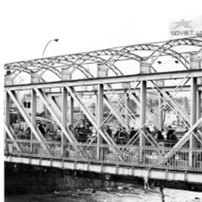
18. Puente peatonal Los Carros Dimensiones: 44 m/peatonal Monumento histórico
