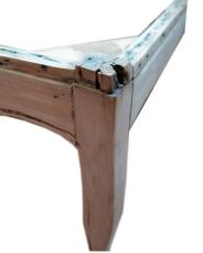
A partir de fotos y un modelado 3d de la silla comenzó el proceso de rediseño de las esquinas, para lograr una pieza firme, consistente y resistente a la pudrición que pudiese reemplazar un sector en la silla muy propenso al deterioro y por otro lado el trabajo de soporte de las cuñas.
