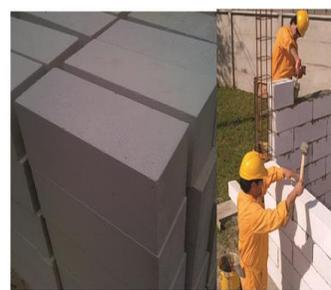
EL BLOQUE ESTRUCTURAL TERMO BLOCK DE HEBEL CUMPLE LOS REQUERIMIENTOS PARA UTILIZARSE EN MURD ESTRUCTURALES O TABIQUES DIVISORIOS, SEGÚN SU ESPESOR; APORTANDO SUS EXCELENTE CALIDADES DE AISLAMIENTO TÉRMICO Y ACÚSTICO. PERMITIENDO UTILIZARSE EN COMBINACIÓN CON OTROS MATERIALES.
