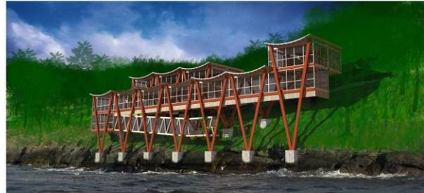
Los módulos terrestres son mas pequeños (6mx3m) porque deben ser levantados hasta lo alto de los pilares solo con ayuda de teclas ya que no es posible instalar una grúa, el primer paso es fundar los poyos de hormigón para montar los mastiles
