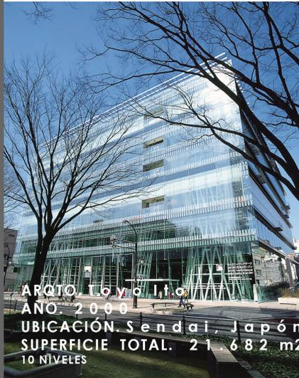
Un bloque transparente y desmaterializado de siete niveles de acero, sostenidos por trece columnas huecas, hechas de una estructura de tubos de acero soldado y pensada con características antisísmicas.
