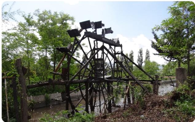
La estructura de estos pintorescos artilugios, contruidos por la mano del artesano local, está diseñada de forma tal que el largo de las piezas de madera son suficientes para una construcción de rotunda lógica: del núcleo central, atravesado por el eje, divergen rayos en cuyos remates se han instalado pequeños recipientes de madera o metálicos llamados “capachos”, que extraen agua del río y la depositan en canales que la conducen hasta las tierras que precisan de ella.
