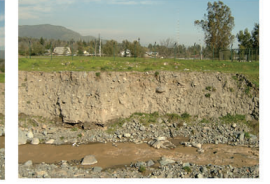
Zona de balcones
