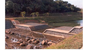
Diques cada 60 mt.
