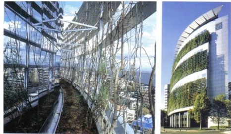
EDIFICIO CONSORCIO CON PIEL VEGETAL QUE CONTROLA LA RADIACIÓN EN VERANO PARA LA ORIENTACIÓN PONIENTE.
