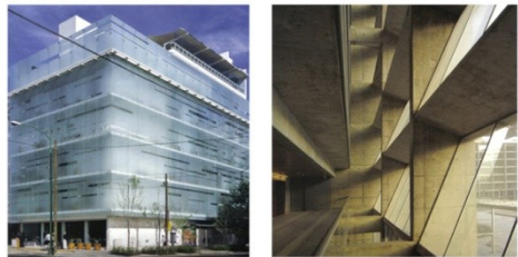
EDIFICIO HABITA DE DOBLE PIEL PARA EL CONTROL SOLAR.
