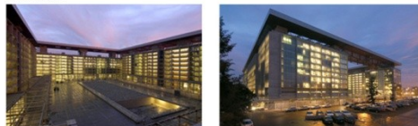
EL CENTRO DE JUSTICIA UTILIZA DOBLE PIEL PARA EL CONTROL SOLAR Y LA VENTILACIÓN.
