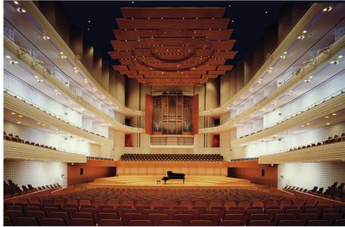
Sala de conciertos de Lucerne. El cielo de la sala sobre el escenario es movable para ajustar los distintos requerimientos acústicos como es el caso de los instrumentos de percusión o los instrumentos de cuerdas.
