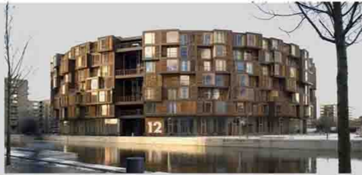
TIETGEN DORMITORY LUNDGAARD & TRANBERG ARKITEKTER CLIENTE: MUNICIPALIDAD TIETGE, DINAMARCA AREA: 26.800 M2 DORMITORIOS: 360
