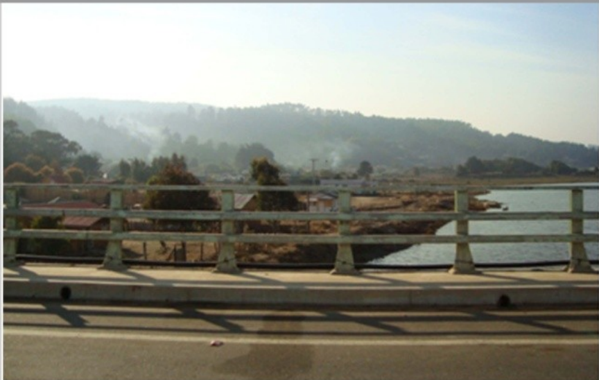
PUENTE MOP _ ACCESO A CAHUIL
