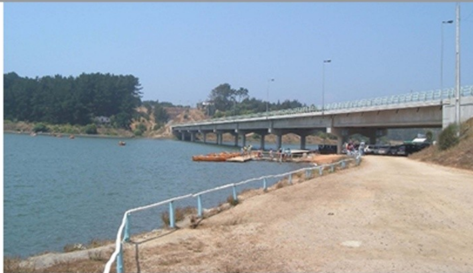
PUENTE MOP _ ACCESO A CAHUIL
