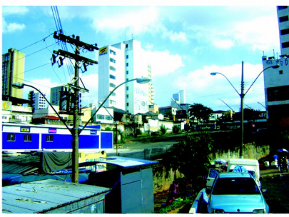
Vista terreno desde nor-este
