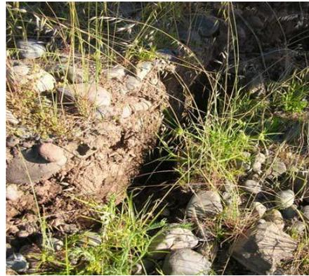
Figura N° 23: Vista general y detalle de grieta paralela al talud de la banquetta estabilizadora
