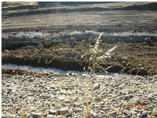
Figura N° 24: Zona excavada y posteriormente rellenada
