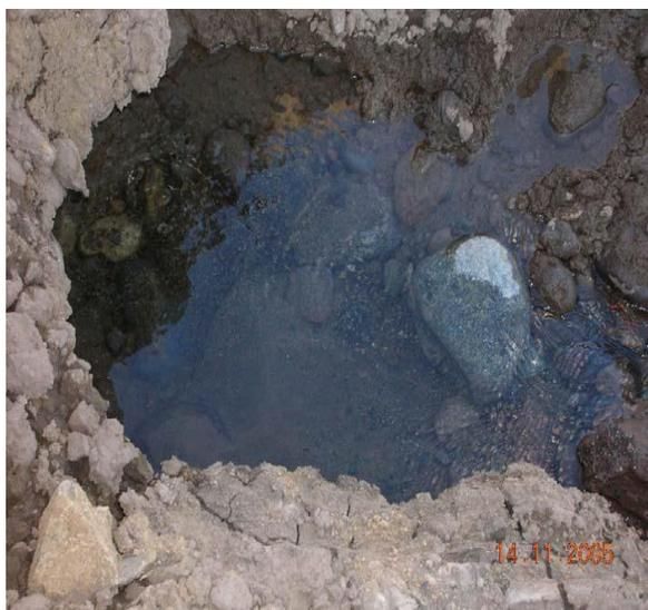
Figura 28: Filtración ascendente a presión, que aparecía inmediatamente aguas arriba de la pared moldeada.
