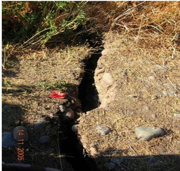
Figura N° 27: Vista general de grieta paralela al talud en el costado sur, frente a zanja excavada.
