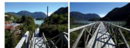
PASARELA COMO CONEXIÓN / CALZADA TORTEL
