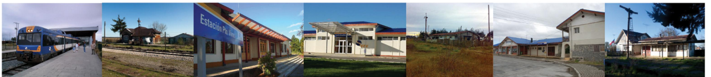
ESTACIÓN PUERTO MONTT
