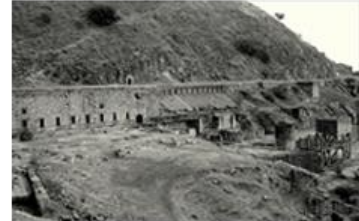
Foto : Ruina Actual, Zona de descarga de material
