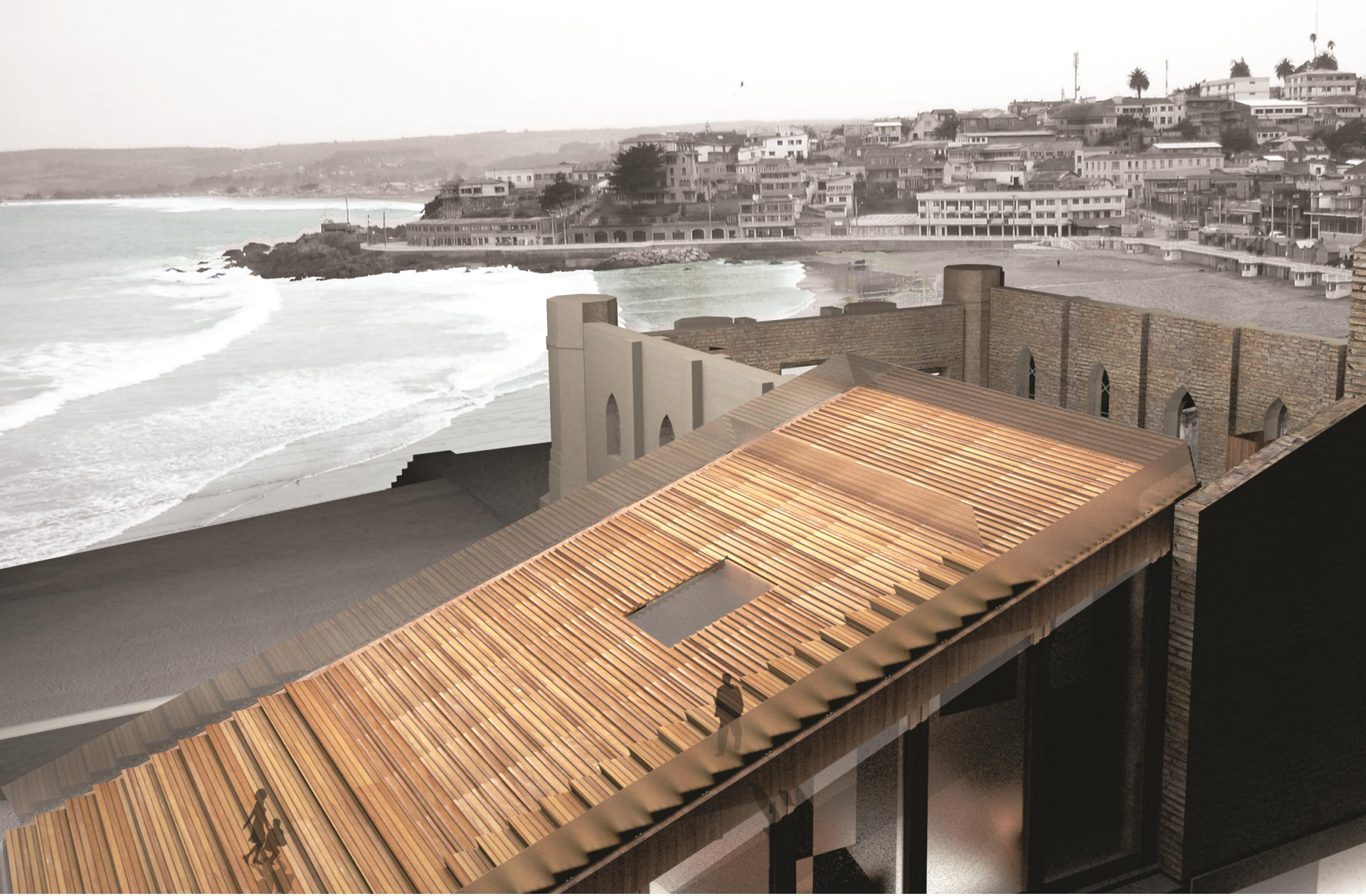
Techo Paseo Exterior
