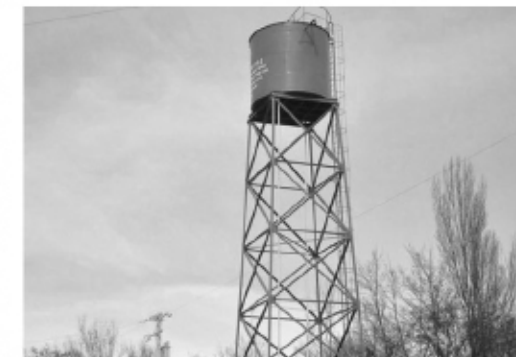
ESTANQUE DE AGUA POTABLE / PANQUEHUE
