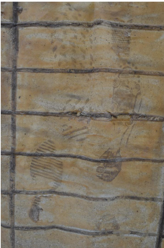
Imagen N° 48. Ejemplo de pisadas de personas distraídas que no vieron la cinta de peligro
