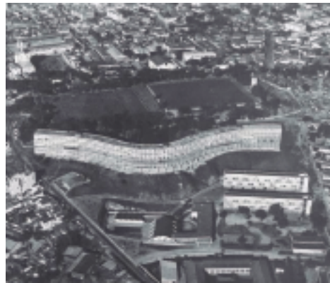
Pedregulho Rio de Janeiro (Brasil), 1946-52 Afonso Eduardo Reidy
